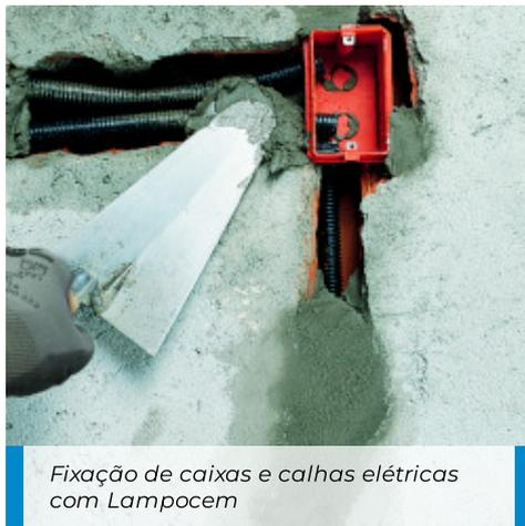
Fixação de caixas e calhas elétricas com Lampocem
